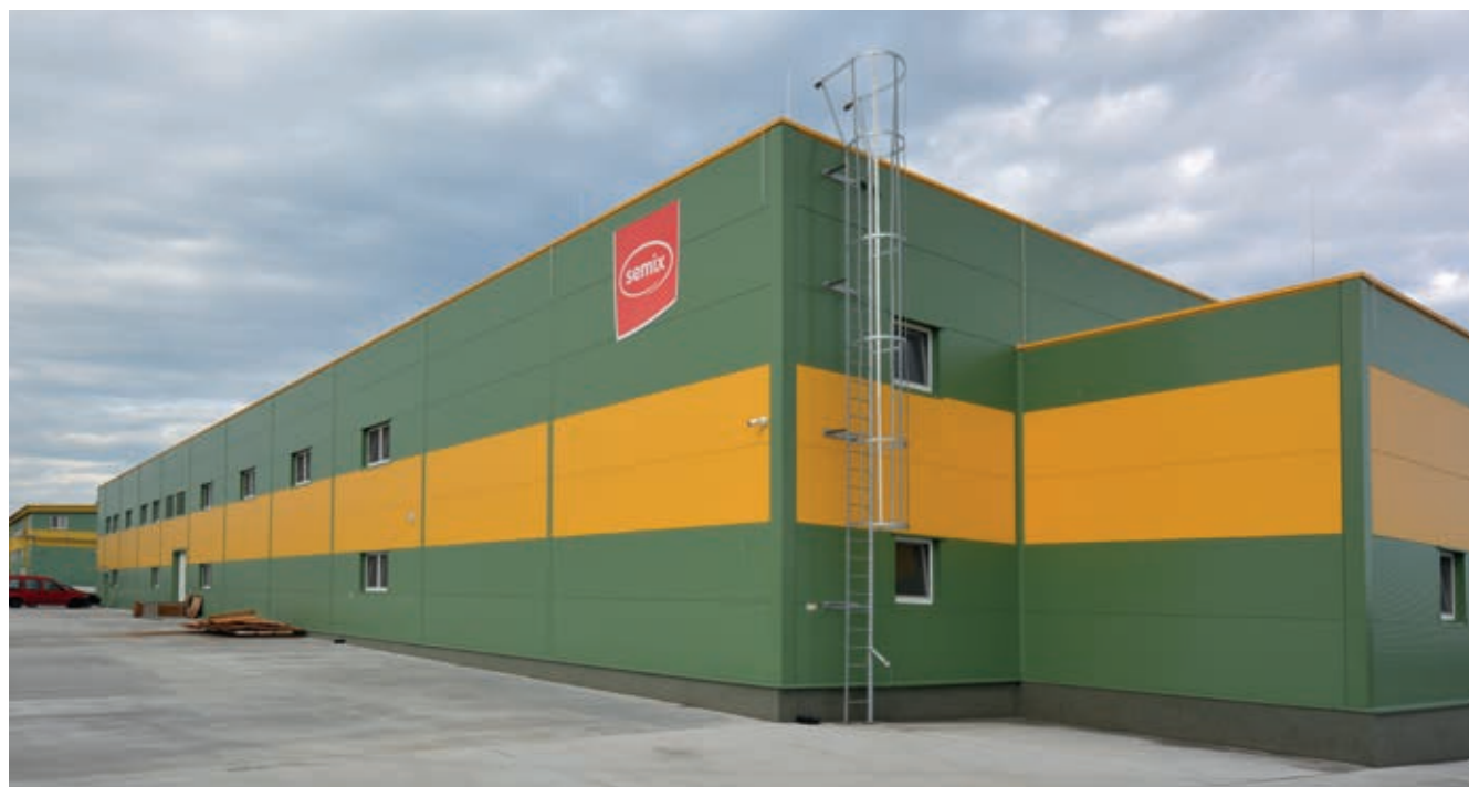
Výrobní hala po dokončení
