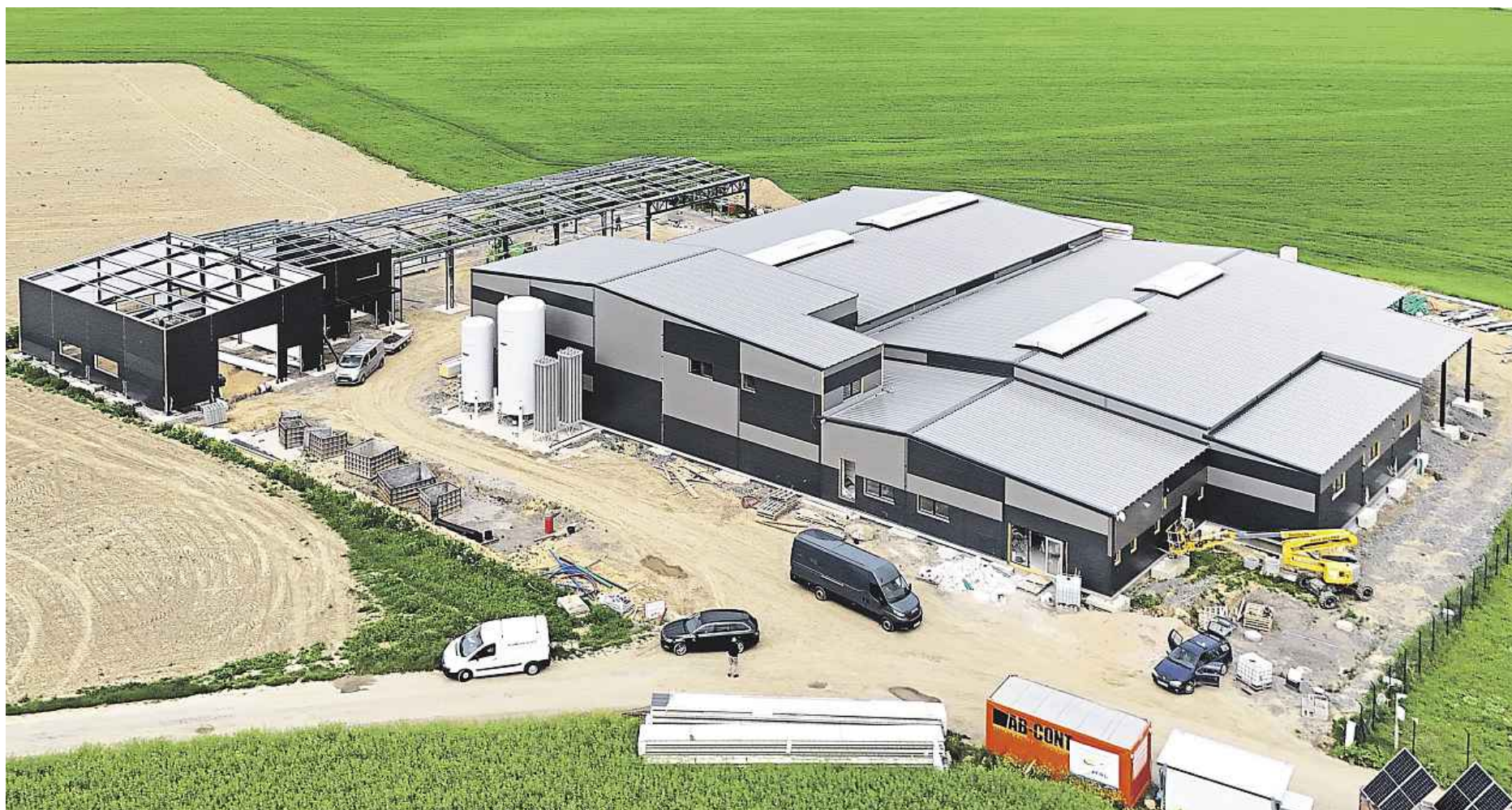
V SOUČASNÉ DOBĚ REALIZUJE UNIHAL VÝROBNÍ HALU PRO PRO SPOLEČNOST IMPEC TECHNOLOGY VE VYSOKÉM MÝTĚ.
