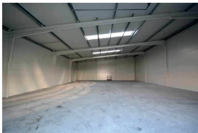
Vnitřní dispozice haly č. 1 s příčkou oddělující jednotlivé části haly
